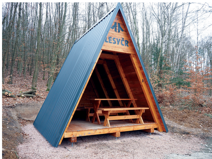
Přístřešek typu „áčko“, určený především pro horské oblasti. Tento stojí U Marušky
